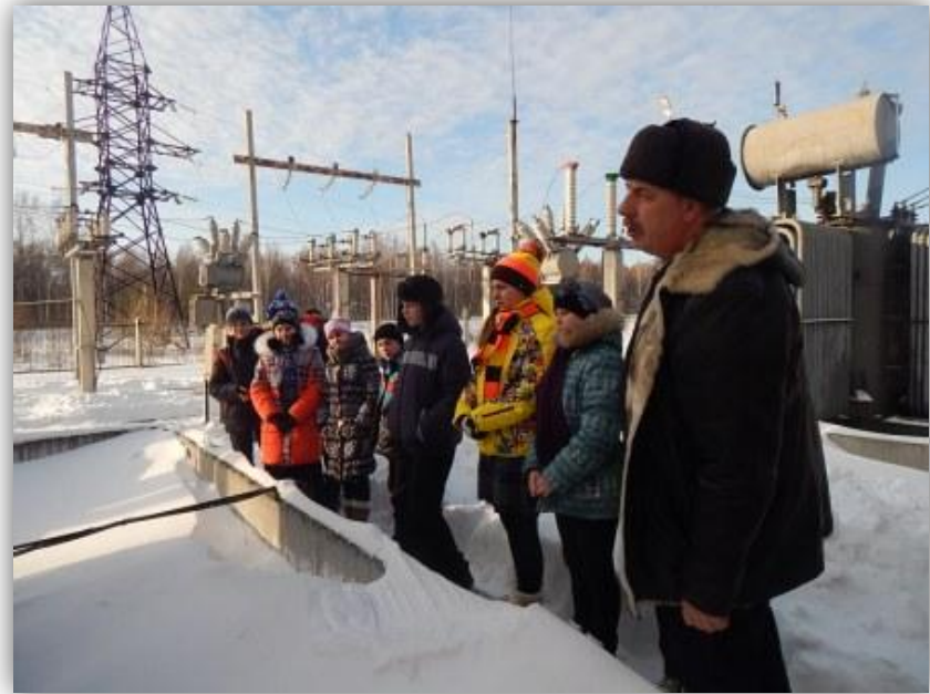
Экскурсия в РЭС ОАО Кузбассэнерго
